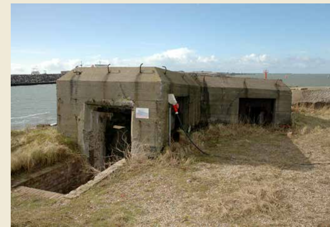
Bunker op Forteiland IJmuiden
