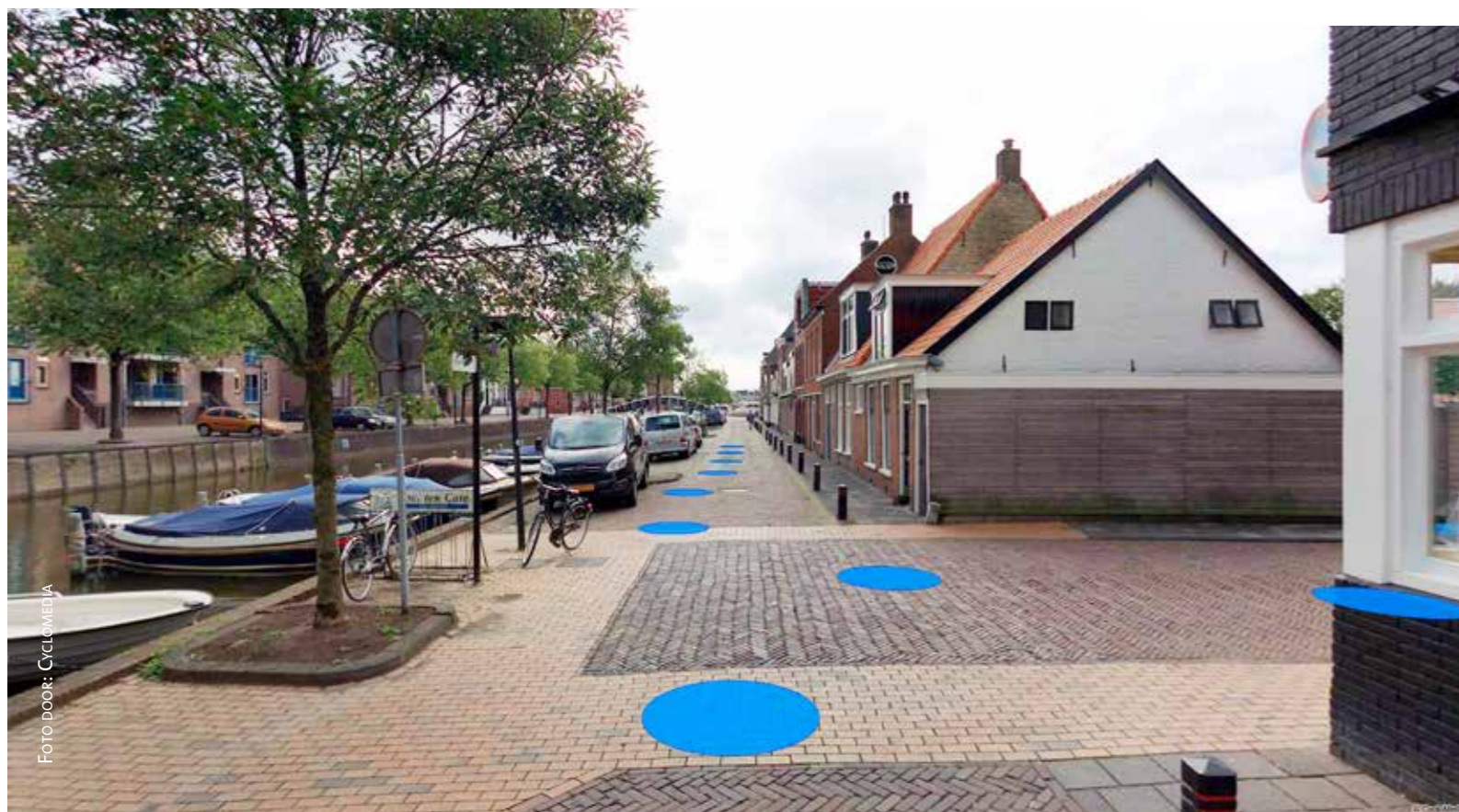
Foto door: Cyclomedia Dit wegvak van de Westersingel in Sneek is in kaart gebracht met de CycleRAP-methode. Er is een wegvak van 25 meter beoordeeld, de beoordelaar kan de lengte aflezen van de blauwe stippen, die iedere 5 meter staan
